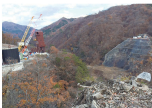
「やんば見放台」から眺めたダムサイト予定地。コンクリートで固められた山肌が痛々しい。
