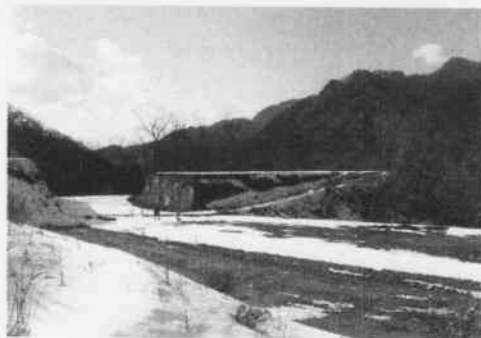
2012年冬のハッ場ダム工事現場風景
