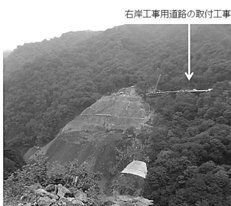
写真1 ダムサイト右岸基礎掘削工事
