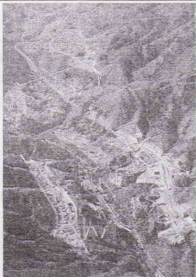
建設再開が決まったハツ場ダムの建設予定地。吾妻川下流から上流を望む。両岸には集落が移転する代償地が並ぶ。手前がダムサイト予定地（21日、群馬県長野原町で共同通信社へリポート）
