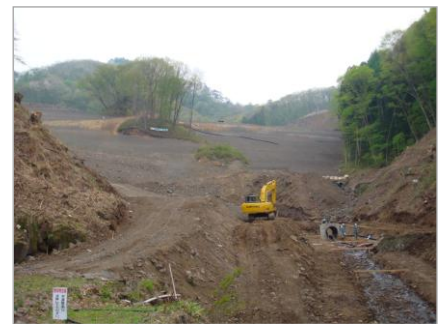
造成中の沢(水はパイプを通して流すから大丈夫というが…) →
