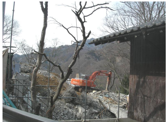
みよしや旅館解体 2011年2月 → (撮影 渡辺洋子)
