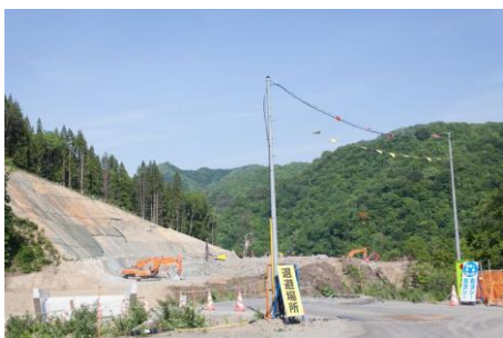
▲本体工事の発破現場。まだら模様の熱水変質帯が露出している。掘削した土砂を吾妻渓谷に落とし込んでいるという。
